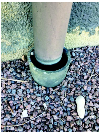
Déclaré - MF1 : BÂTIMENT / FACADE - Conduit - EP- (Présence d'amiante)
