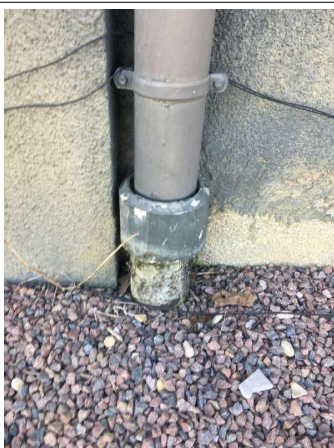
Déclaré - : FACADES - Conduit- (Présence d'amiante)
