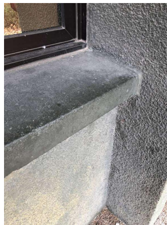
Prélèvement - P058 : FACADES - Enduit de lissage- (Présence d'amiante)
