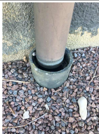
Déclaré - : FACADES - Conduit- (Présence d'amiante)
